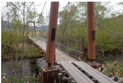
ヨッピー吊橋 8:27 揺れてビックリ
